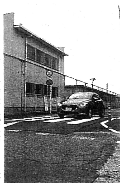
小学校沿いの交差点に設置されたスムーズ横断歩道（福山市で）
